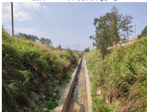
照片 8 A 段起点现状
