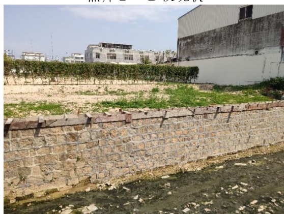
照片 4 B 段挡墙及还未浇筑增高部分
