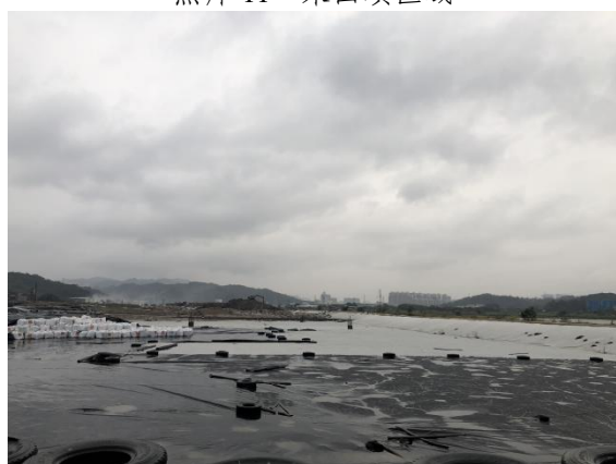
照片 13 未回填区域
