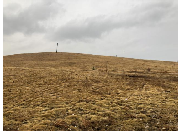
照片 8 已填埋区域及排水沟
