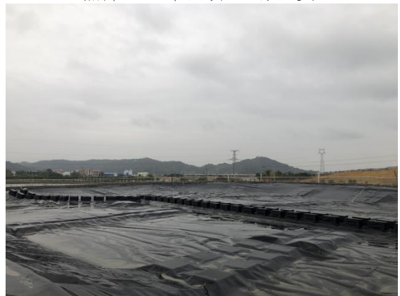
照片 14 未回填区域
