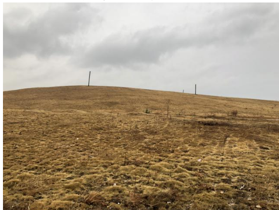
照片 8 已填埋区域及排水沟
