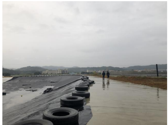
照片 12 未回填区域及道路
