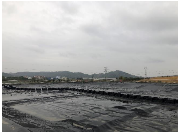
照片4 填埋区现状
