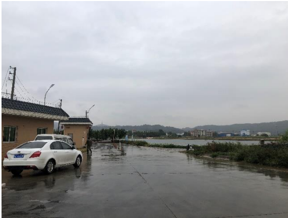
照片 1 出入口现状
