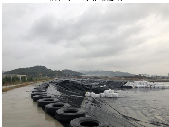
照片 11 未回填区域
