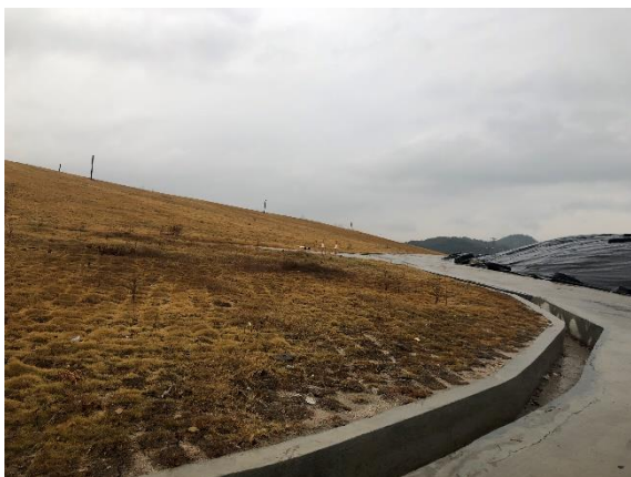
照片3 填埋区现状
