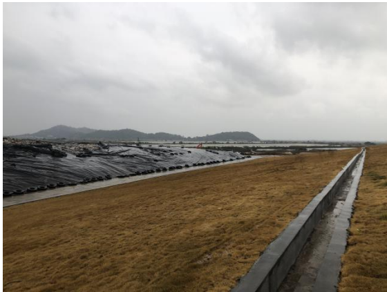
照片 5 项目内排水沟
