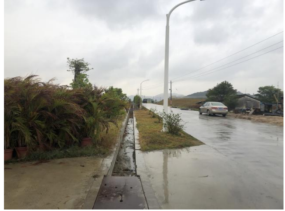
照片 16 项目出口排水沟
