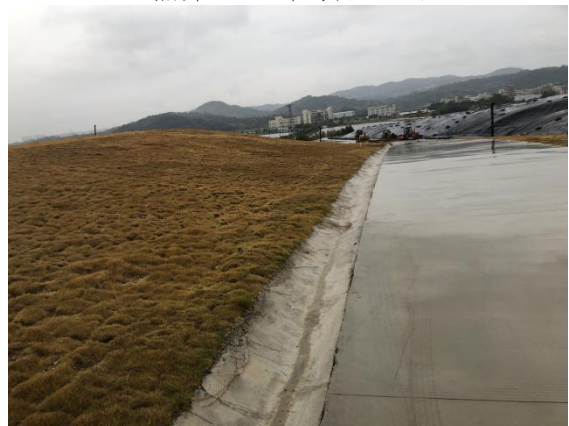
照片 4 项目内道路及排水沟
