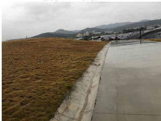
照片 4 项目内道路及排水沟
